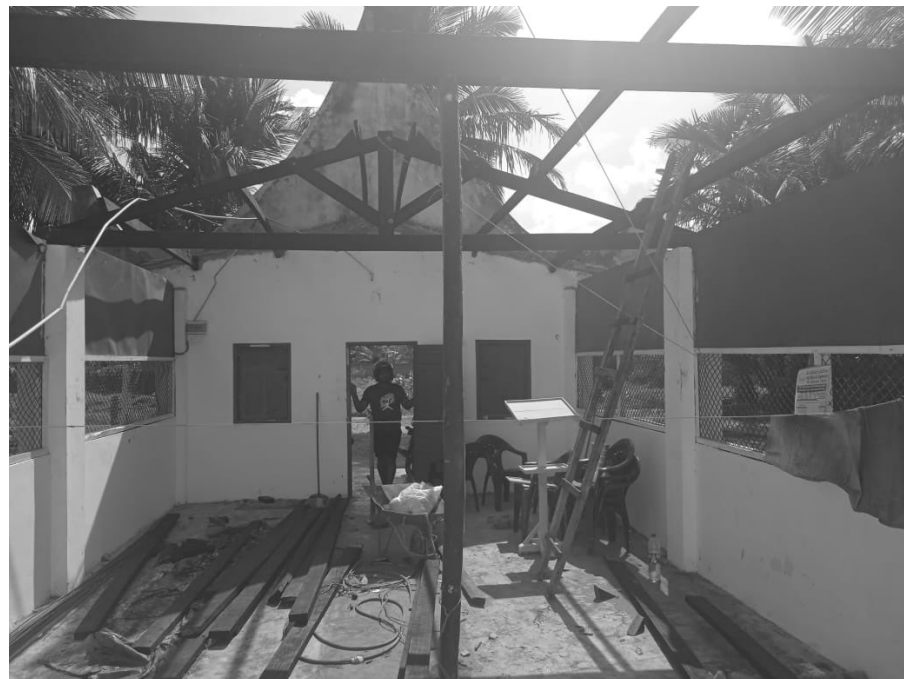
Die Kirche in Munrampidi erhält ein neues Dach
